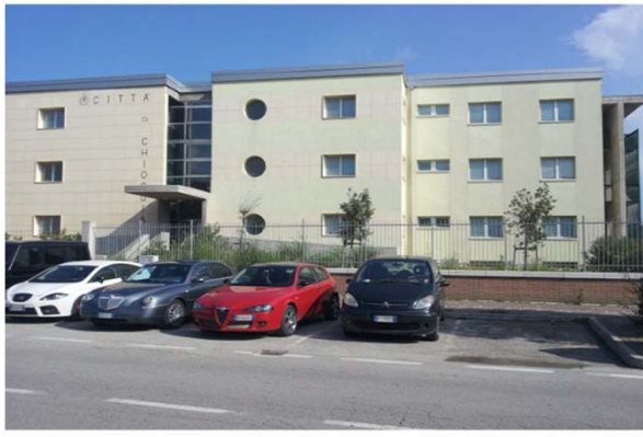
001-vista prospetto ovest
