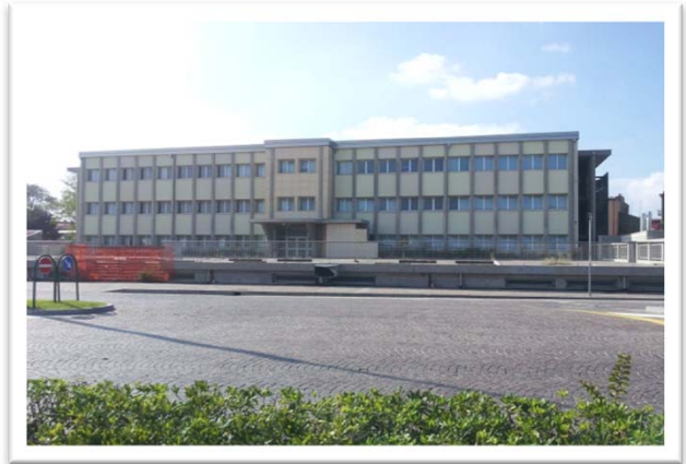
010-vista prospetto est
