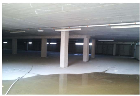
015-vista autorimessa interrata
