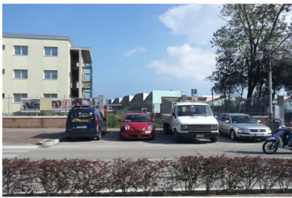
003-vista prospetto ovest
