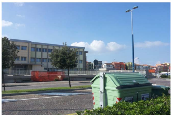
011-vista prospetto est
