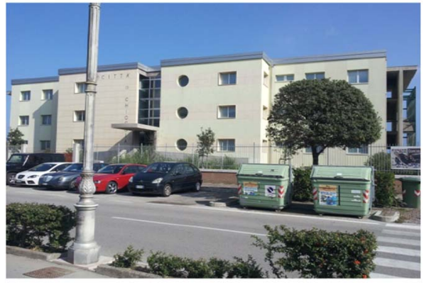
002-vista prospetto ovest
